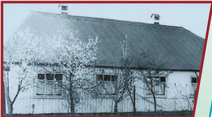
Этот дом был разрушен. (г. Иссык)
